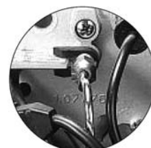
Regulación de la cabeza de combustión
