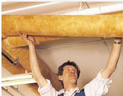
Aislamiento de tuberías
