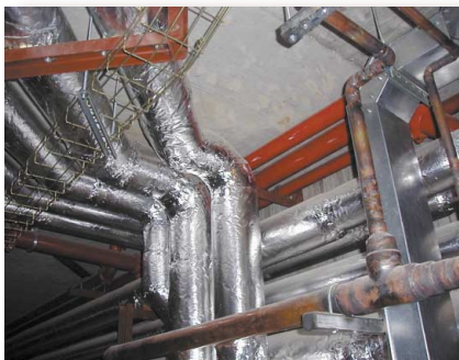
Aislamiento de tuberías
