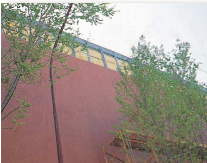
Cerramientos verticales y cubiertas sandwich
