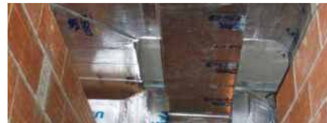
Superficie externa en una red de conductos ya montada e instalada. Podemos observar como el logotipo de la compañía y la marca de producto quedan visibles.
