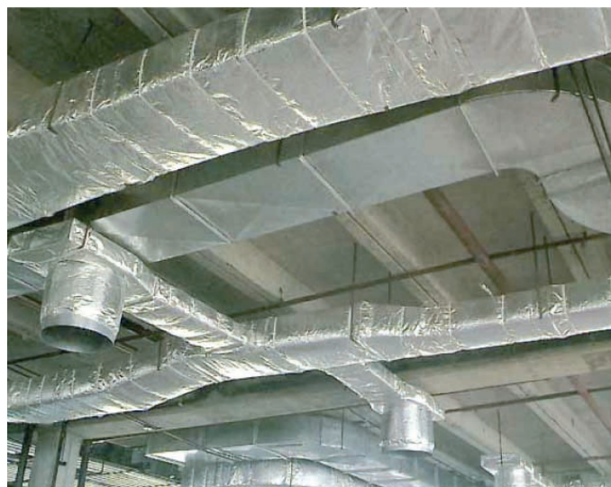
Aislamiento exterior de conductos
