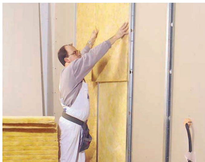
Tabiquería seca, divisorios
