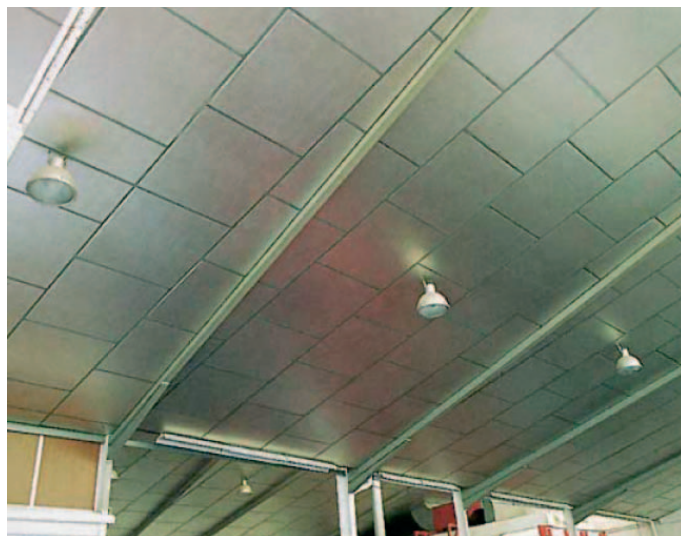
Techos termoacústicos, naves
