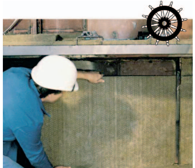
Calorifugado en alta temperatura de depósitos y equipos. Protección contra el fuego.
