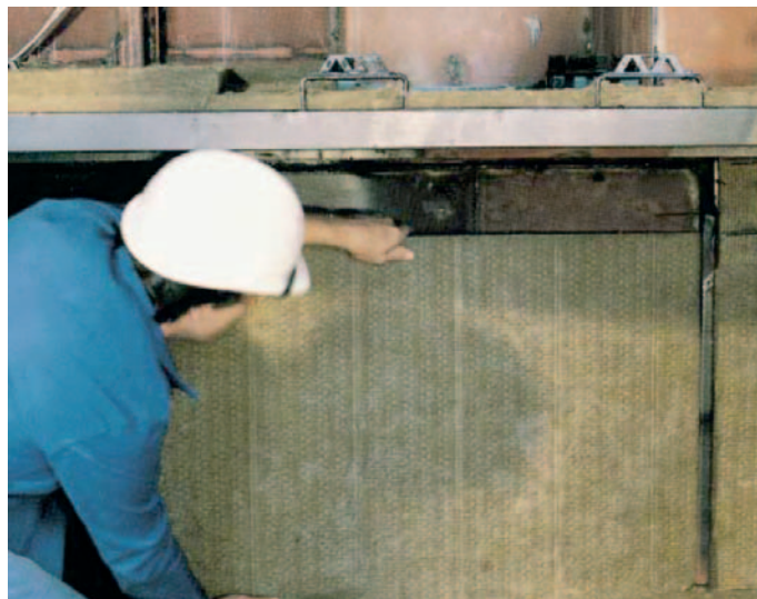
Calorifugado en alta temperatura de depósitos y equipos. Protección contra el fuego
