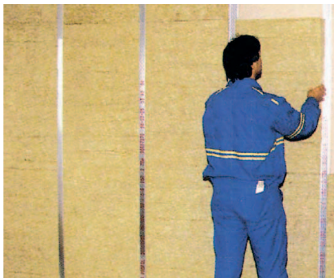
Tabiquería seca, divisorios
