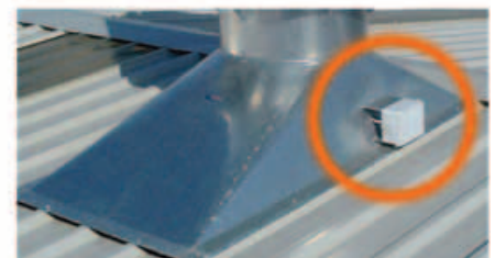
Servomotor: accionamiento automático del Registro
