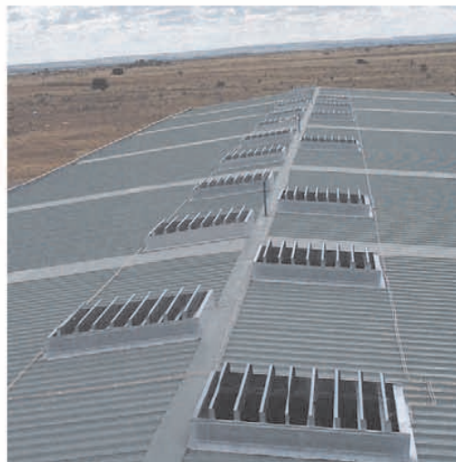
Instalación de Exutorios AEX-LN en cubierta
