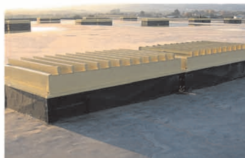
Instalación de Exutorios AEX-LM en cubierta
