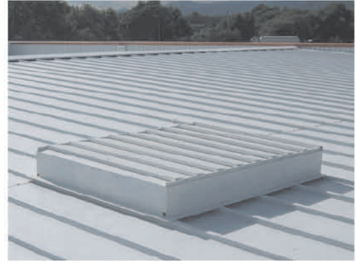
Instalación de Exutorios AEX-LF en cubierta
