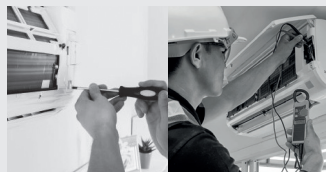
Difícil conexión eléctrica
