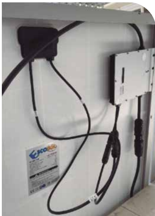
▲ Detalle modulo con microinversor atornillado.
