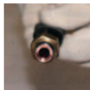
4. Control visual de la buena realización del ensanche
