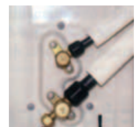
7. Finalización del empalme
