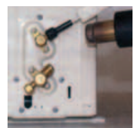
6. Finalización del empalme
