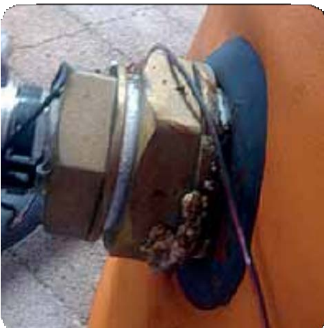
Ejemplo conexión a depósito sin manguitos anti-dieléctricos
